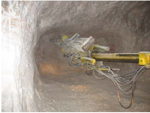
Bohren der Sprenglöcher
