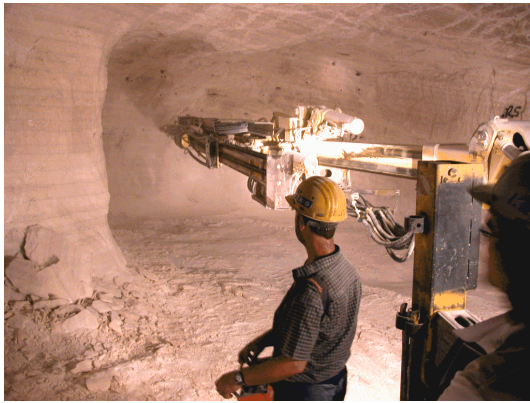
Bohren der Löcher für die Sprengung
